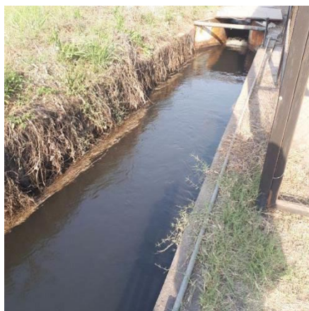
FG115: Aforador de control de caudal
