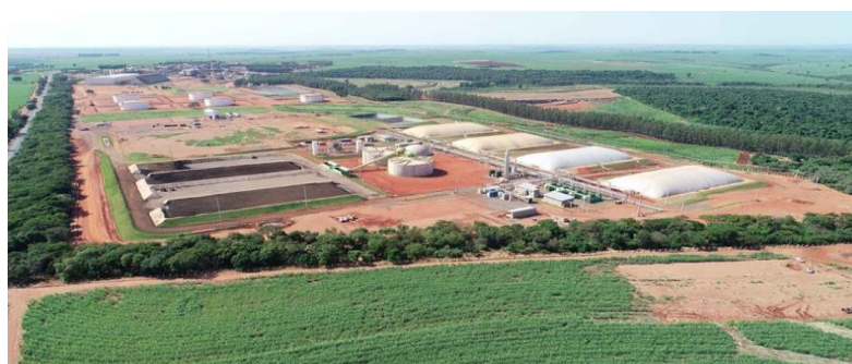
FG165: Vista general de la digestión anaeróbica de Cocal Energía
