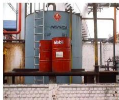
FG14: Tanque recolector de aceite y tanque de almacenamiento de aceite usado
